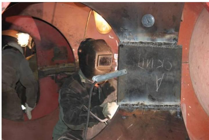
После установки вставок, на ребро жёсткости, по рекомендации завода-изготовителя, был установлен дополнительный пояс усиления.
