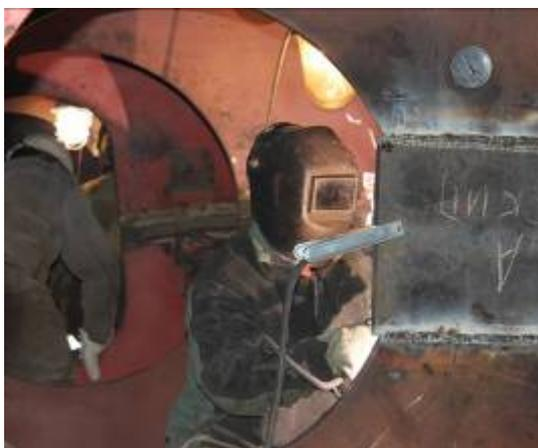
Рис. 5 Ремонт ребёр жёсткости ШПМ
