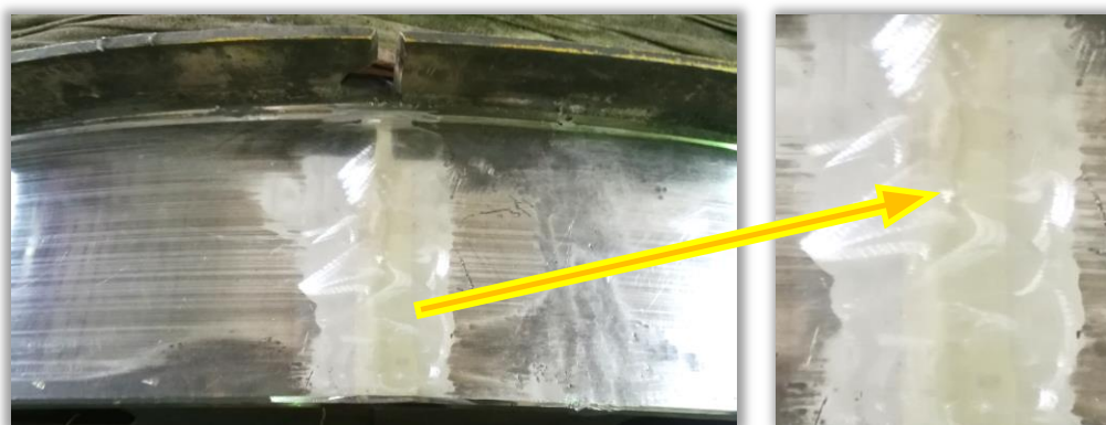
Рис. 5. Тормозное поле после ремонта
