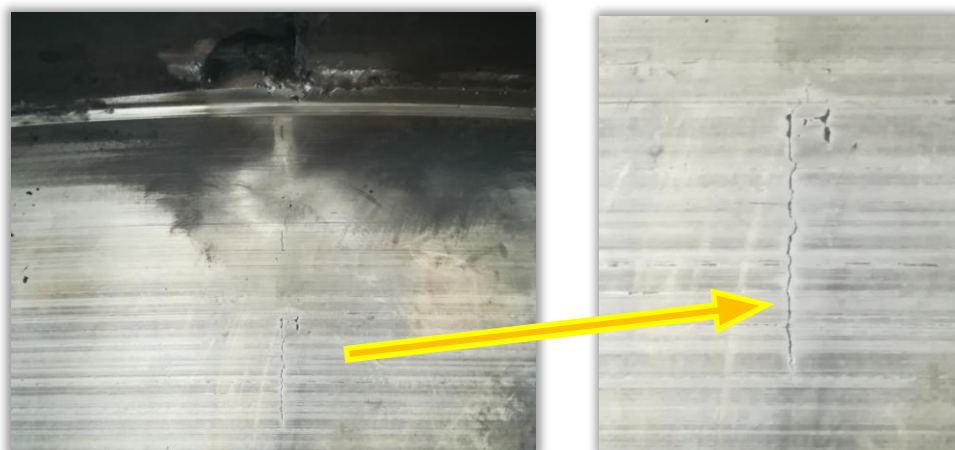
Рис. 3. Трещина по стыку сегментов
